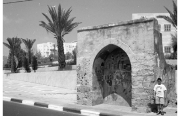
الشكل 2. سبيل عسقلان قبل أعمال الصيانة والترميم
