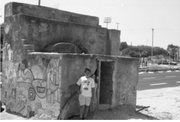
الشكل 3. سبيل عسقلان قبل أعمال الصيانة والترميم
