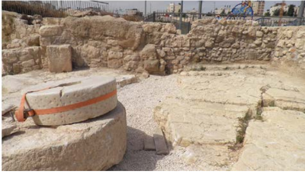
الشكل ٤. أعمال الصيانة في المعصرة. استخدام الجص في تثبيت الجدران وملء الشقوق بالحصى في الصخور الطبيعية.
