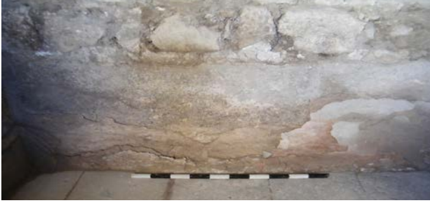
الشكل ١٤. طبقات القصارة على الحائط الجنوبي لمسطبة الدهس الجنوبية.
