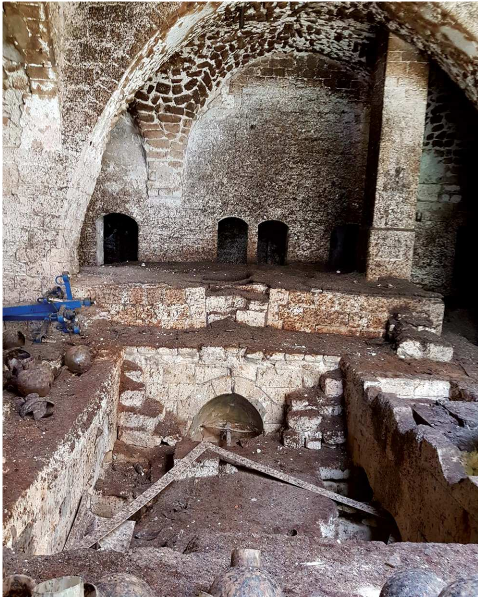
الشكل 9. بقايا من الأحواض الخلط لمكونات التبخر ومرجل طهي الصابون في مصبنة دامياني (تصوير: الكاتب، 2018).
