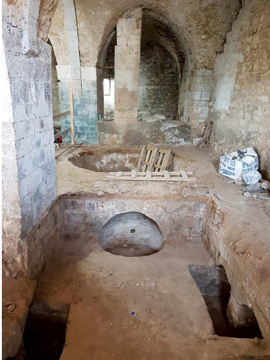
الشكل 11. بقايا أحواض خلط المواد المخثرة ومرجل طهي الصابون في مصبنة مركز أوري غيلر (تصوير: الكاتب، 2018).
